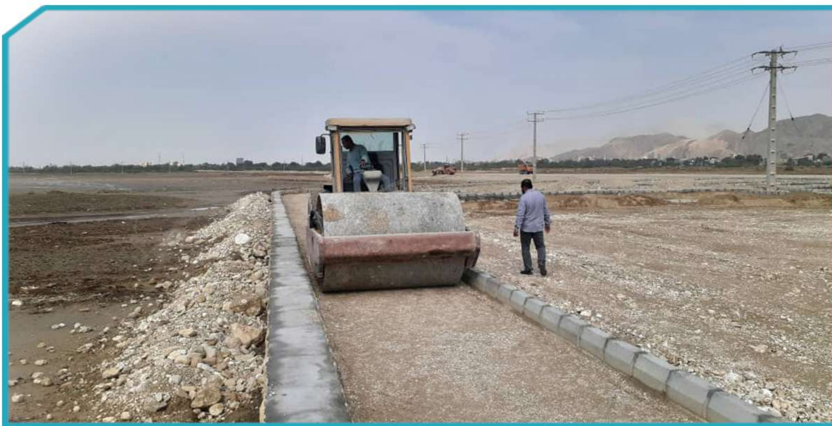
احداث پیست دوچرخه سواری به عرض ۲/۵ متر و طول ۶۰۰ متر
