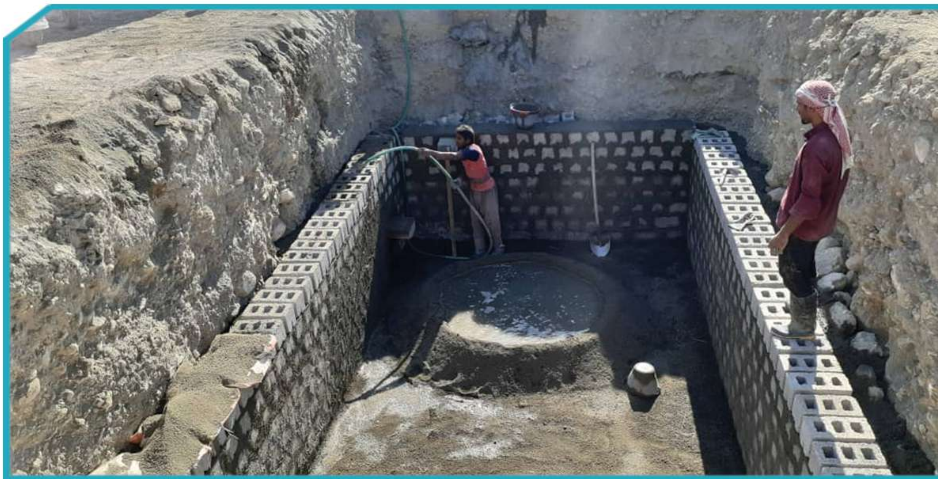
احداث محزن ۷۰ هزار لیتری آب جهت تغذیه بلوار ورودی و میدان حرا
