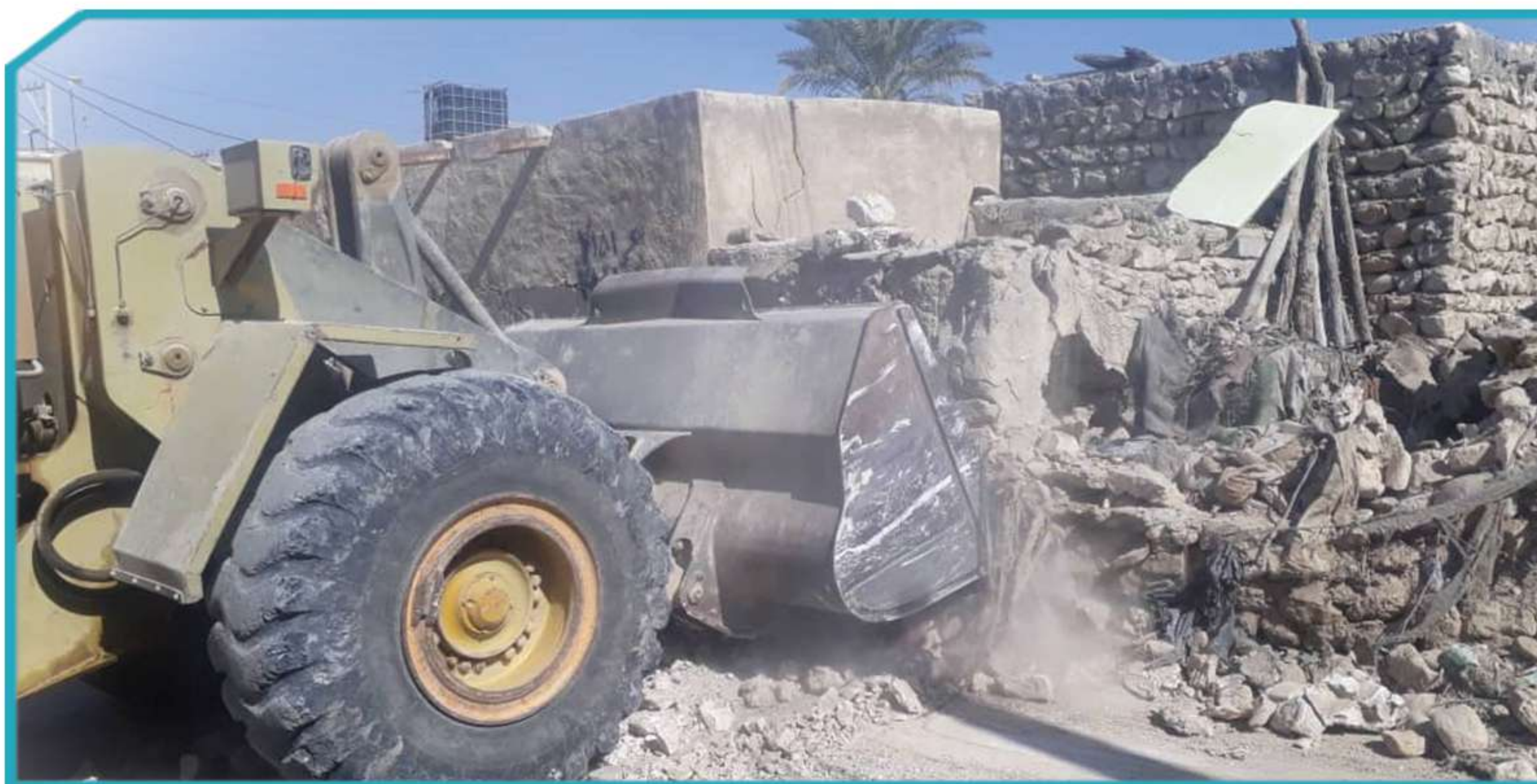
پاکسازی خانه های مخروبه و نخاله برداری
