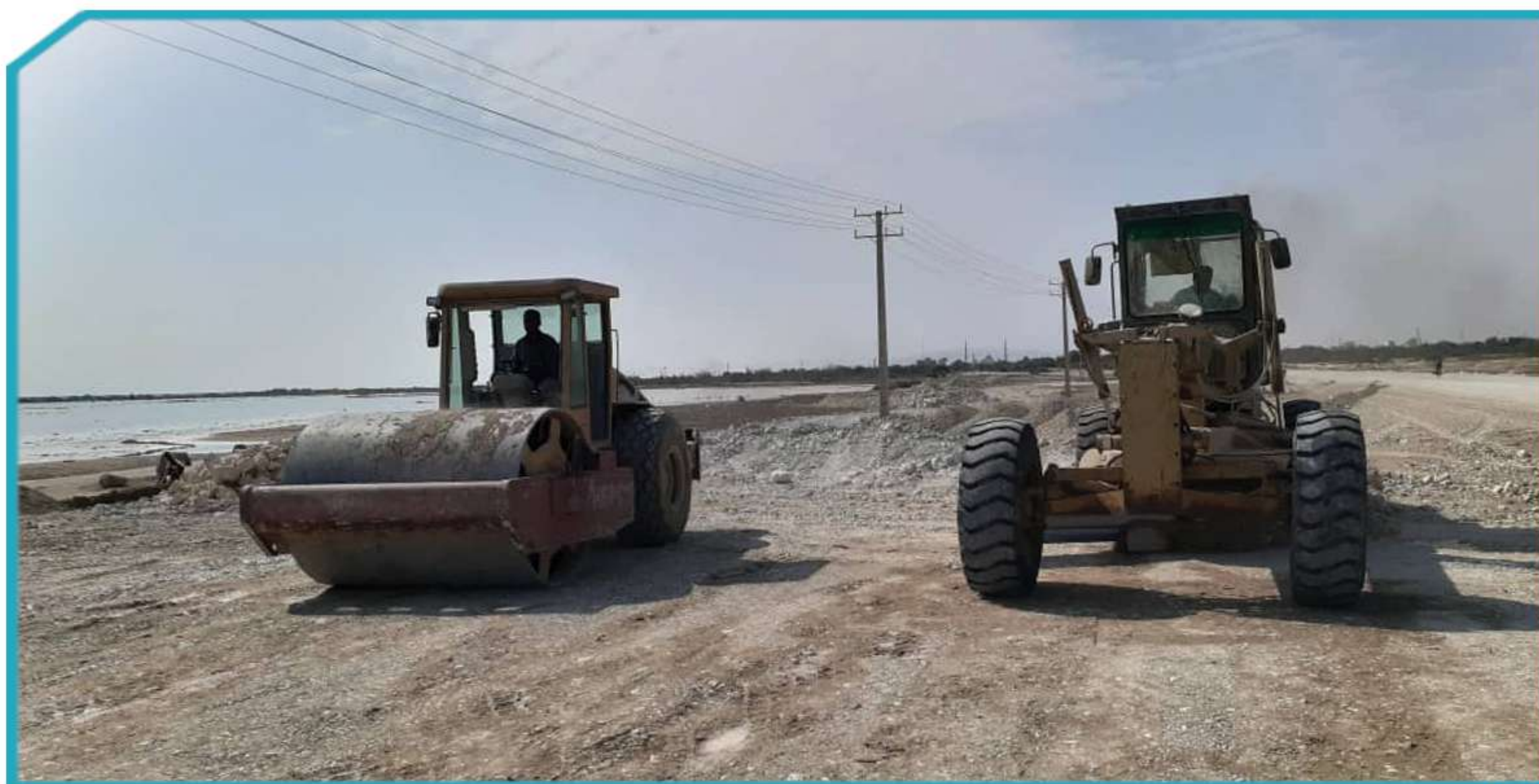
بار ریزی و تسطیح محوطه به حجم ۱۰۰۰۰ مترمکعب
