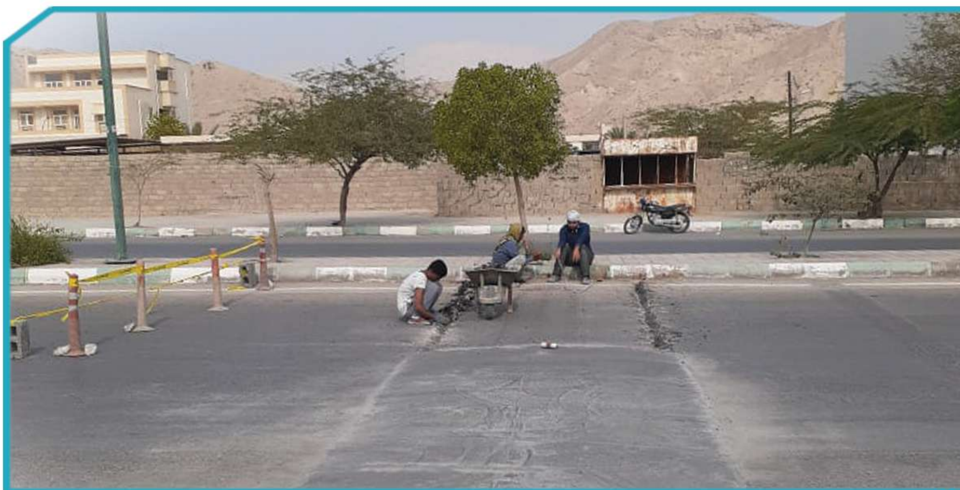
نصب سرعت گیرهای بتنی
