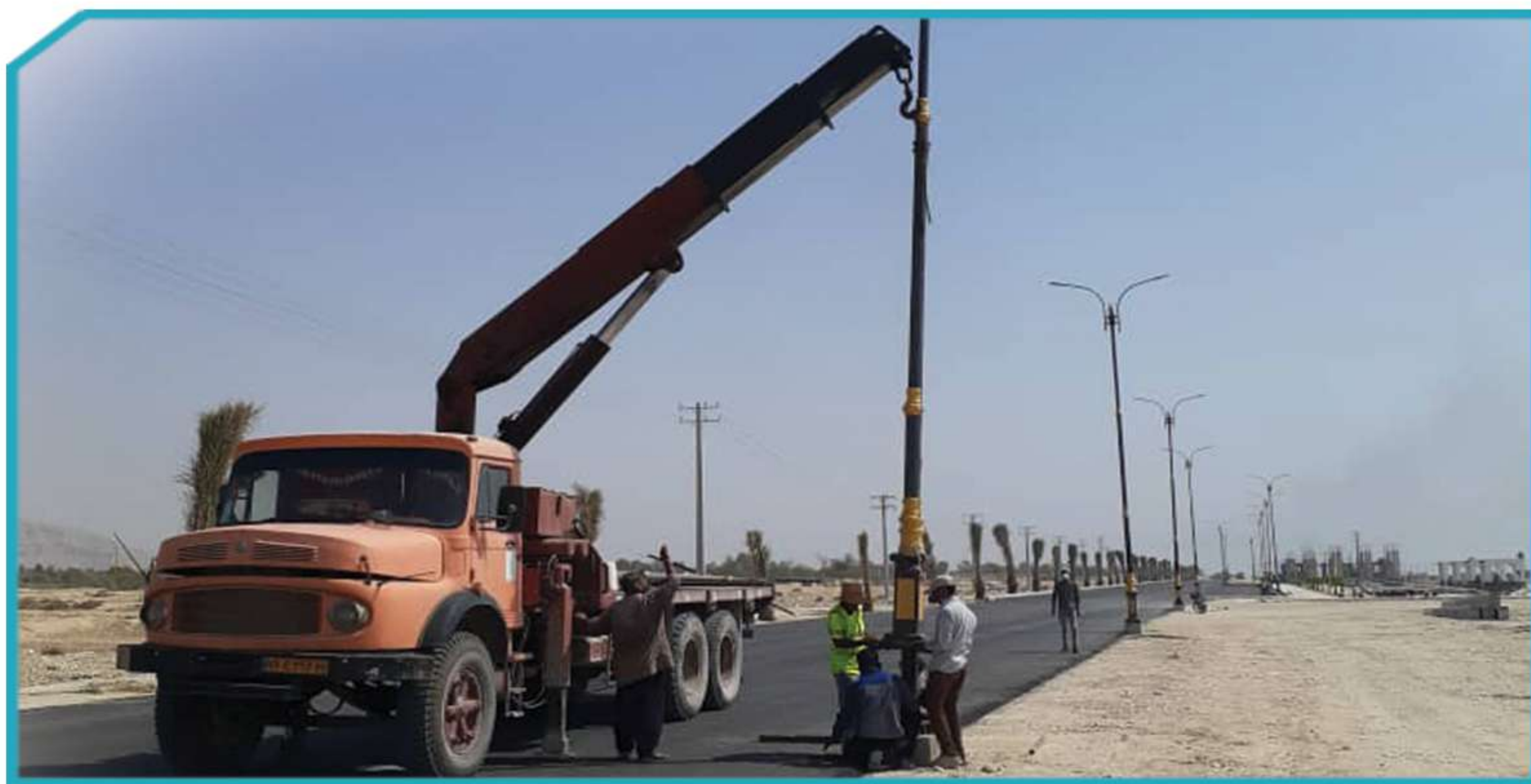
نصب پایه های روشنایی به تعداد ۵۰ عدد
