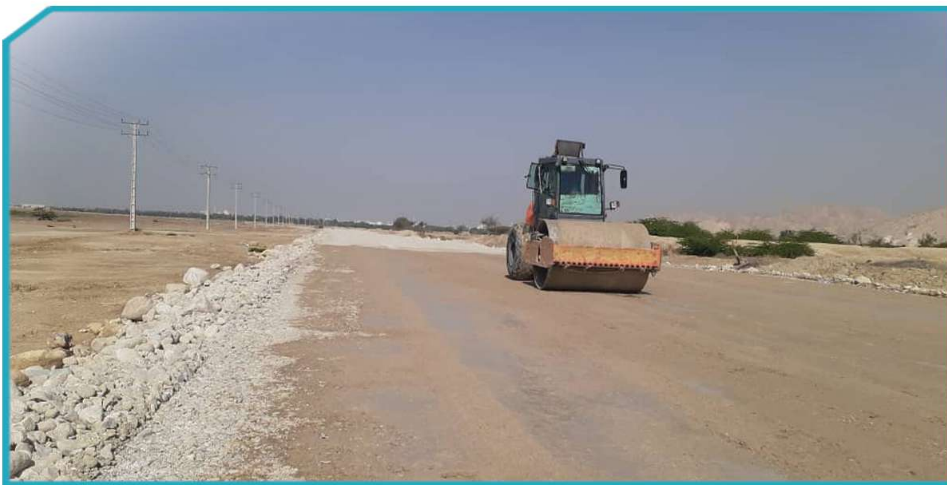
خاک ریزی و پخش به حجم ۱۴۴۰۰۰ مترمکعب
